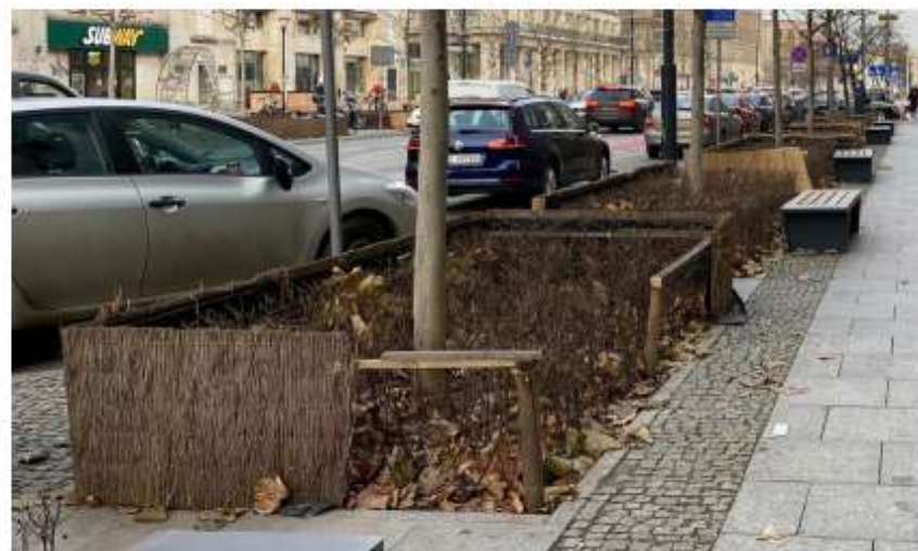
Устройство защитных матов от реагентов со стороны проезжей части на зимнее время, Варшава
