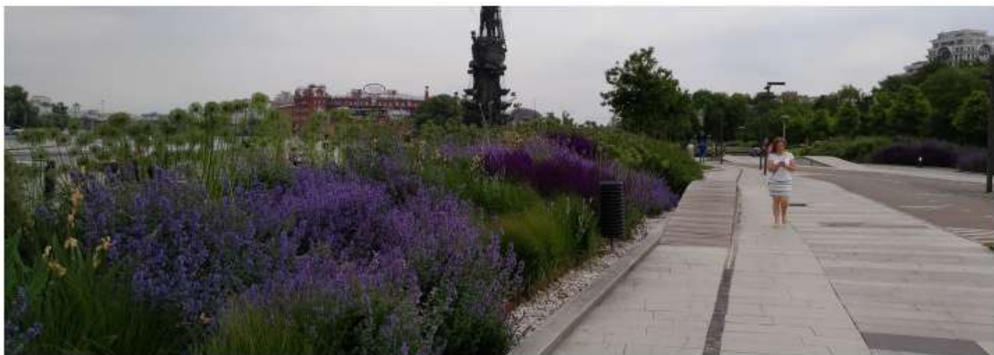
Дренажный канал по периметру холма с отсыпкой из гальки, Москва
